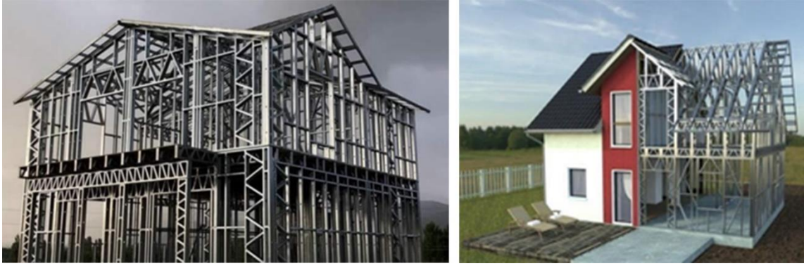
Görsel 5. Çelik Prefabrik Yapı Örnekleri [11]- [12]
